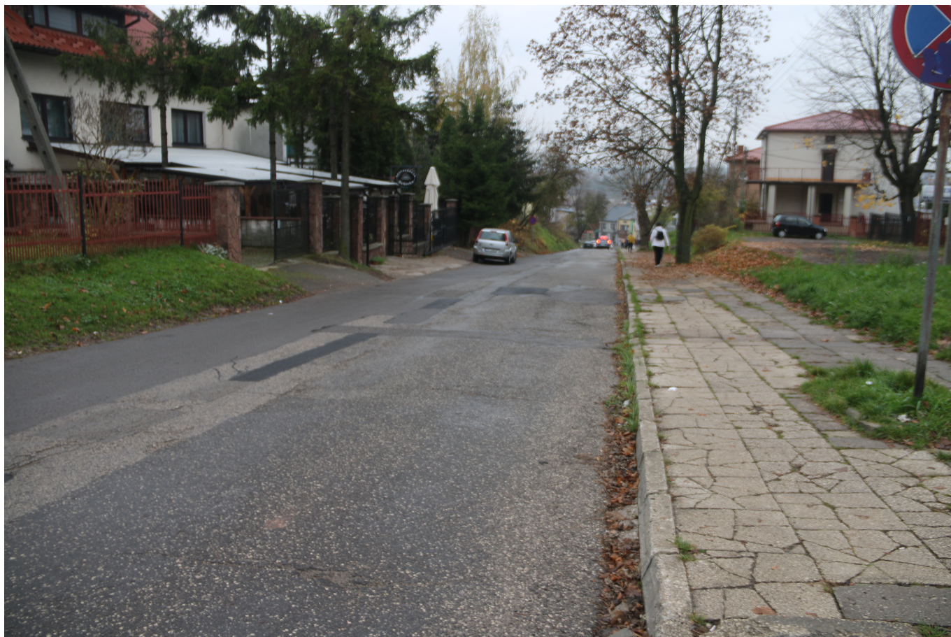
Ulica Kilińskiego po remoncie:
